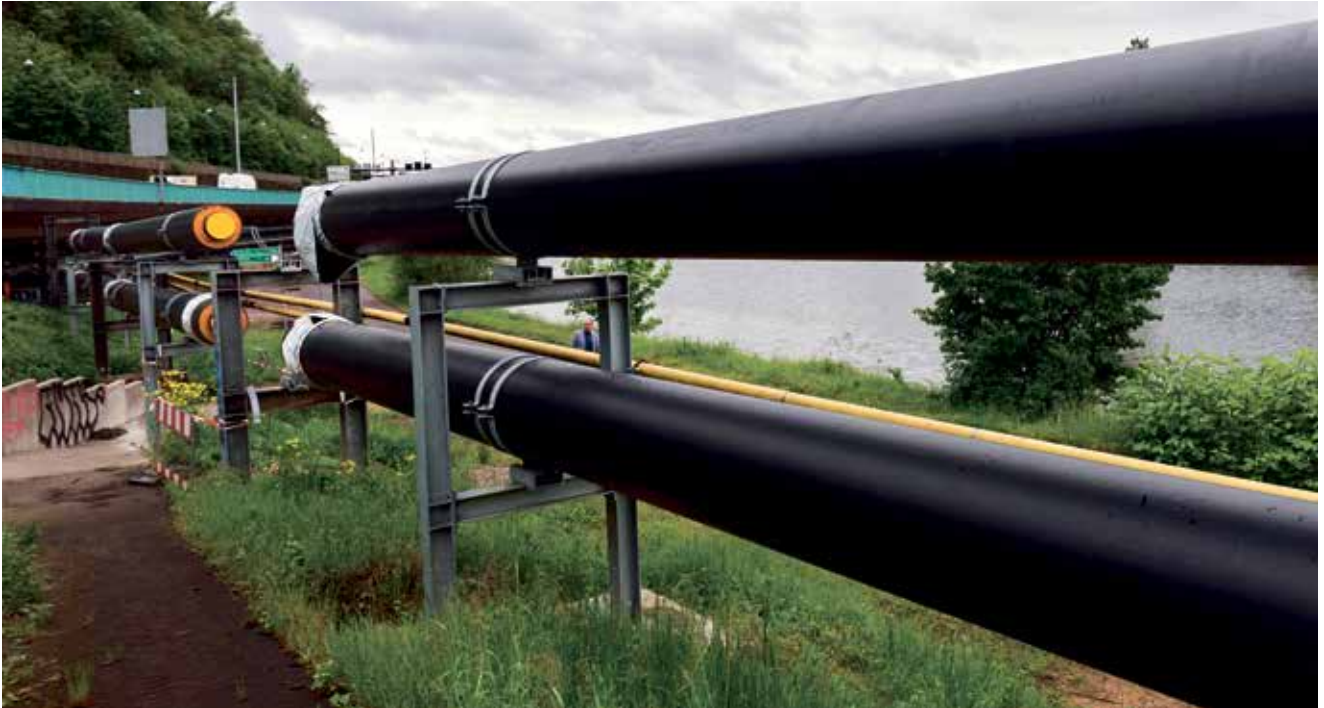
Der Fernwärmeausbau in Saarbrücken schreitet voran. Auch für Unternehmen kann sich der Anschluss an das Fernwärmenetz lohnen.
