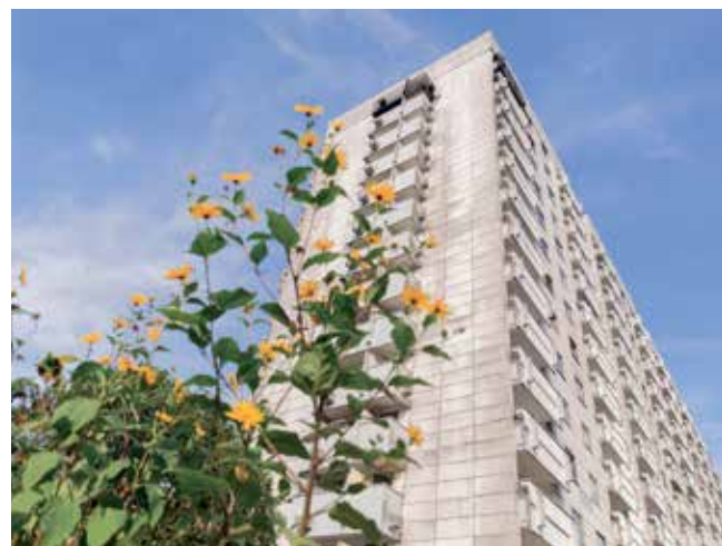
In der Wohnanlage Irgenhöhe wurde von Energie SaarLorLux eine Heizung mit Blockheizkraftwerk und zwei Gas-Spitzenlastkesseln realisiert.
