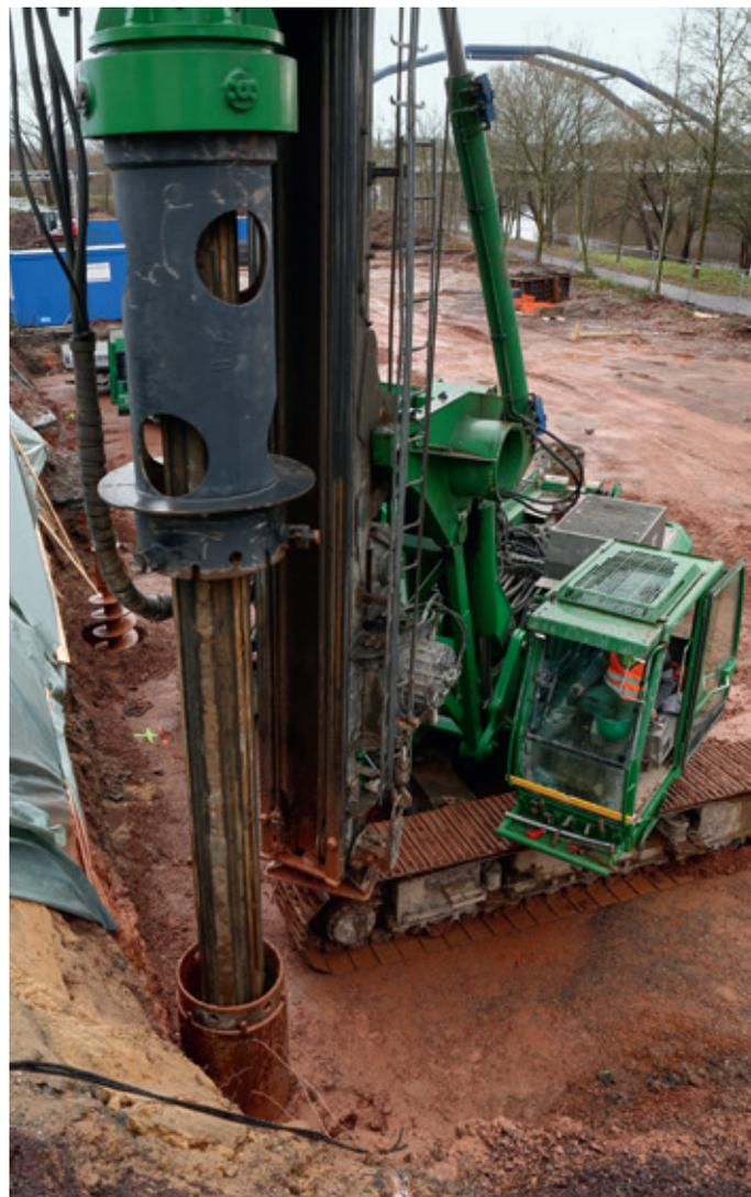
Bohrung für die Löcher der Pfähle, auf denen später das Fundament der Gasdruckregelmessstation liegt.
