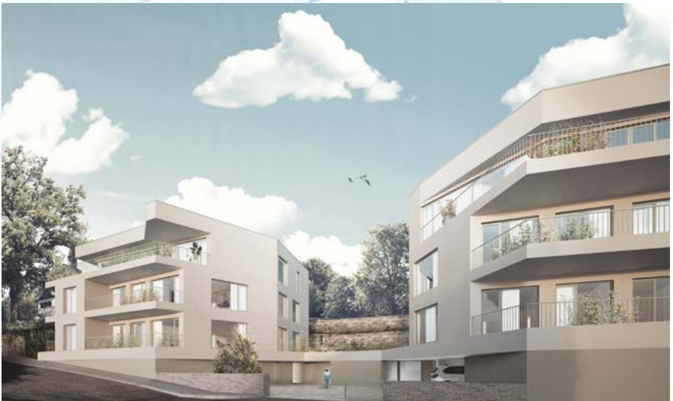
Modernes Wohnen in historischem Umfeld: Die künftigen Bewohner können sich auf Wohnungen in Gebäuden mit kristallinen Strukturen oder ruhige, sonnige Villen mit Blick in den Park freuen.
